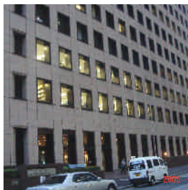
セントラルビル
